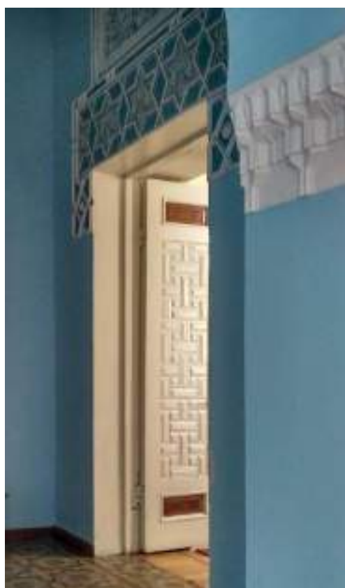
Филёнчатая дверь дворца «Дюльбер» (наши дни). Фигурные петли и ручки утрачены
