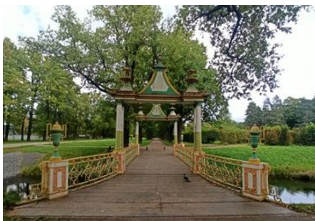
Малый китайский мост в Александровском саду Царского Села. Фото автора, 2025 г.
